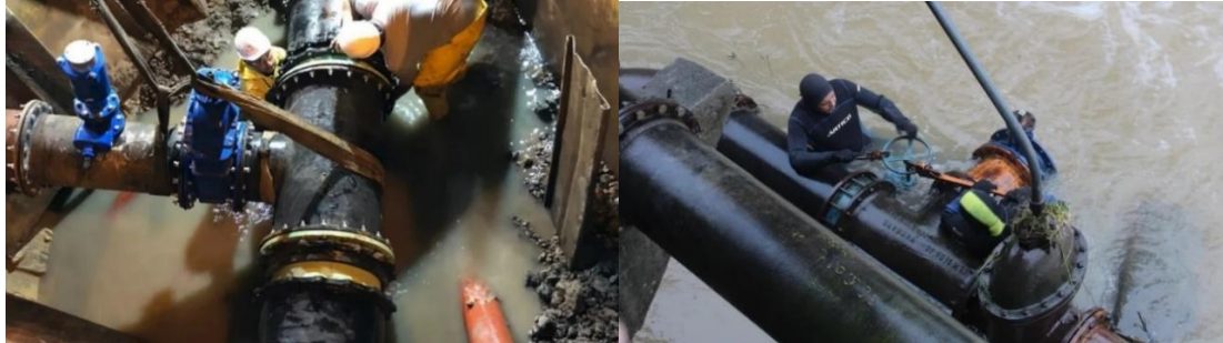
Figuras 4 e 5 - Equipes operando para reparar os sistemas enfaticamente prejudicados
